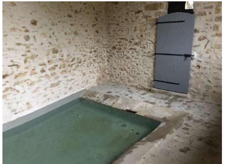
Etanchéité du bassin et fabrication porte bois (lavoir des Etards)
