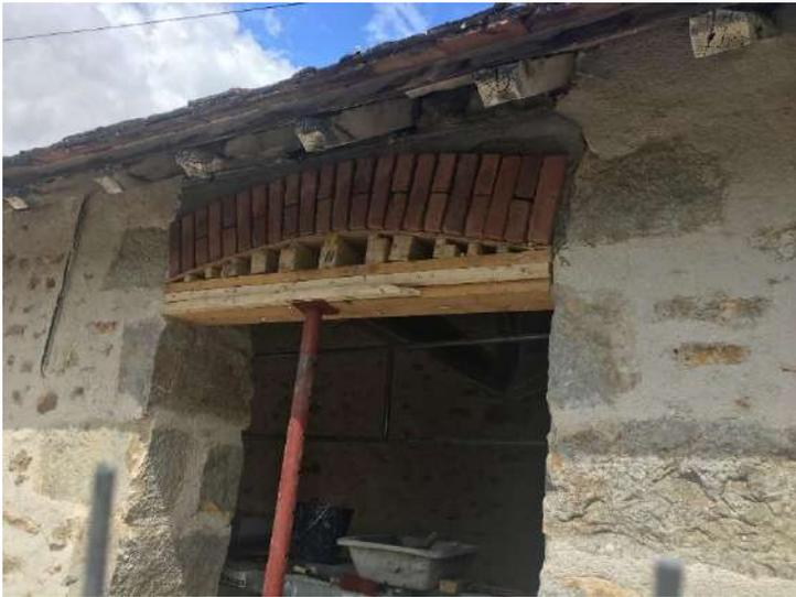
Renforcement d'un linteau en béton armé avec parement en briquettes (lavoir des Etards)
